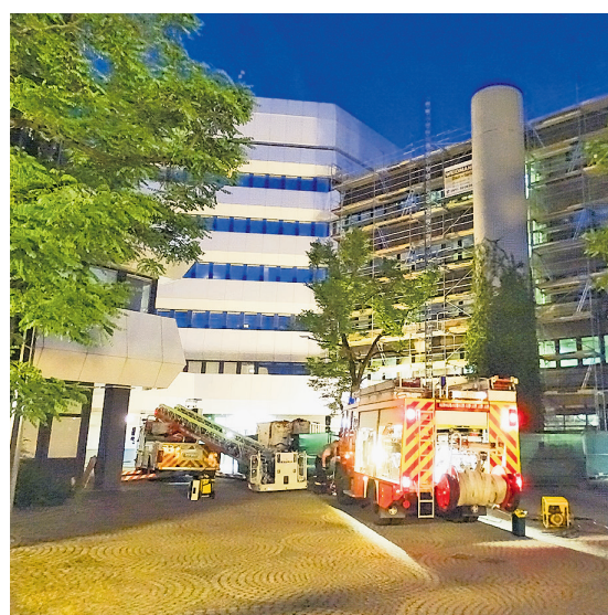
Immenser Schaden entstand bei einem Wassereintritt am Landratsamt in Lauf. Foto: Feuerwehr
