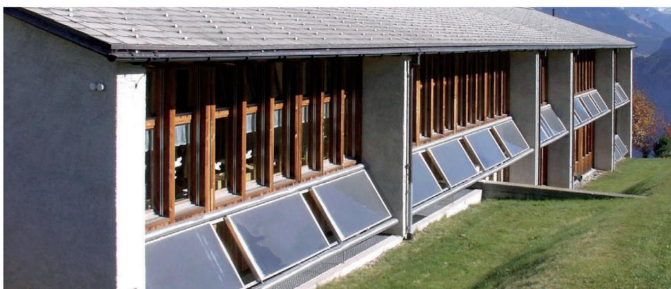
Thermische Solaranlage für die Warmwasseraufbereitung sowie Heizungsunterstützung. Durch den steilen Anstellwinkel der Kollektoren optimiert sich der Ertrag im Winterhalbjahr.
