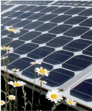
Die Solarzellen erzeugen Gleichstrom, welcher mittels Wechselrichtern in Wechselstrom umgewandelt wird, bevor die Energie in das Netz eingespeisen werden kann.
