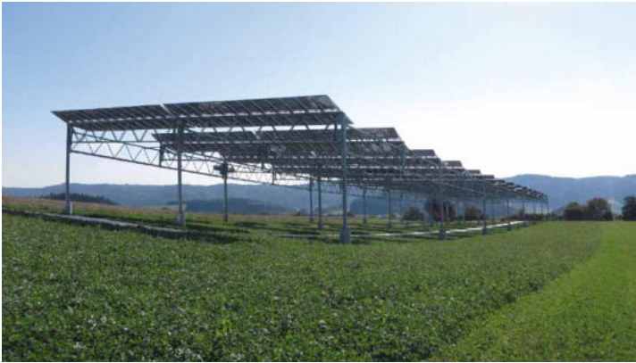
Lange verband man mit Agri-Photovoltaik in Deutschland vor allem diese Forschungsanlage des Fraunhofer ISE in Heggelbach aus dem Jahr 2016. Sie erlaubt Landmaschinen, darunter durchzufahren.
