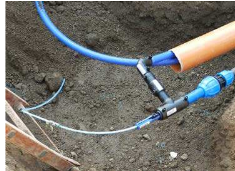
Abbildung 18: Verlegung in Gas- und Frischwasser- leitungen
