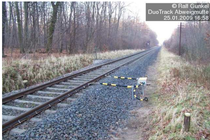
Abbildung 20: Kabelmontage an Schienenwegen – hier mit Abzweigmuffe
