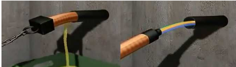
Abbildung 19: Extraktion bzw. Auspressen von bestehenden Kupferkabeln
