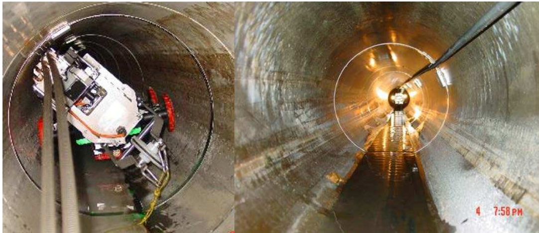
Abbildung 15: Verlegung im Abwasserkanal mit Verlegeroboter
