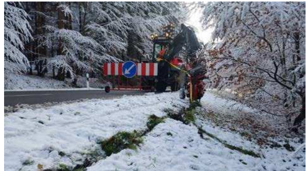
Abbildung 5: Einsatz des Kabelpflugverfahrens unter erschwerten Witterungsbedingungen
