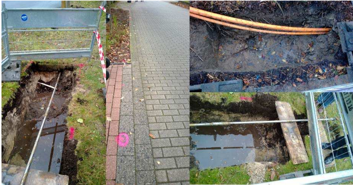
Abbildung 8: Kopfloch, Straßenoberfläche mit Markern, Kabeleinführung und Bohrendstelle bei Anwendung des Horizontalpülbohr-Verfahrens
