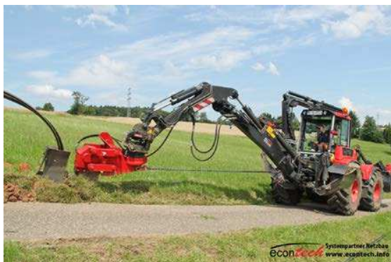
Abbildung 4: Peter-Kabelpflugverfahren
