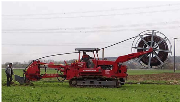
Abbildung 2: Anwendung des Kabelpflugverfahrens für Energieleitungen
