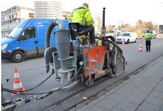
Abbildung 12: Nano-Trenching
