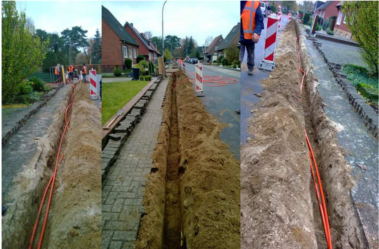
Abbildung 1: Offene Verlegung in leicht reduzierter Tiefe
