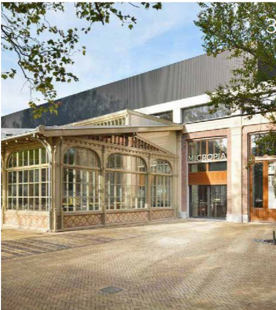
Rijbanen gebakken klinkers (geel/bruin) Referentie: artisplein Amsterdam
