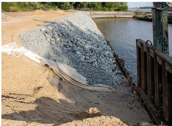
**Die Hafenanlage wird hochwassersicher mit Steinen aufgeschüttet**
