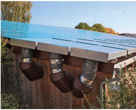
**Über diese Rohre im Vordergrund** wird die Warmluft aus den Kollektoren angesaugt. Die Luftkollektoranlage besteht aus drei Reihen à 47,5 m Länge und 1 m Breite.
