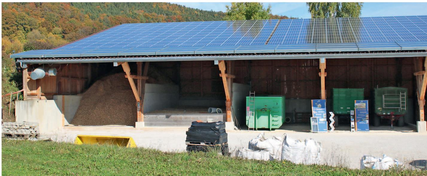
Auf dem Dach der Trocknungshalle von Johann Bauer sind neben einer PV-Anlage auch 143 m<sup>2</sup> große Luftkollektoren verbaut.
