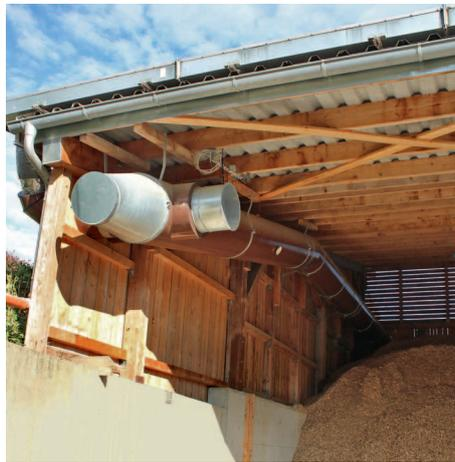
**Kühlere Außenluft** kann hier nach Bedarf automatisch zugemischt werden.
