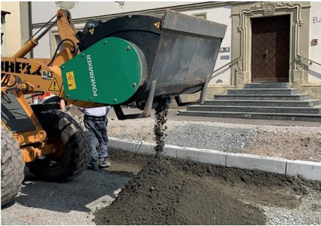
Mit dem Powermixer von Kronenberger oecotec ist es möglich vor Ort den Beton in der gewünschten Kondition und der gewünschten Menge herzustellen. Zum einen ist es kostengünstiger kleinere bis mittlere Mengen Beton selbst herzustellen; der eigentliche Vorteil liegt aber
