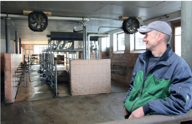
Im Melkstand von Peter Maurus sorgen zwei kleine Ventilatoren für einen angenehmen Luftzug – die bisherigen Ventilatoren in der Mitte will Peter Maurus noch entfernen, weil diese zu laut sind.
