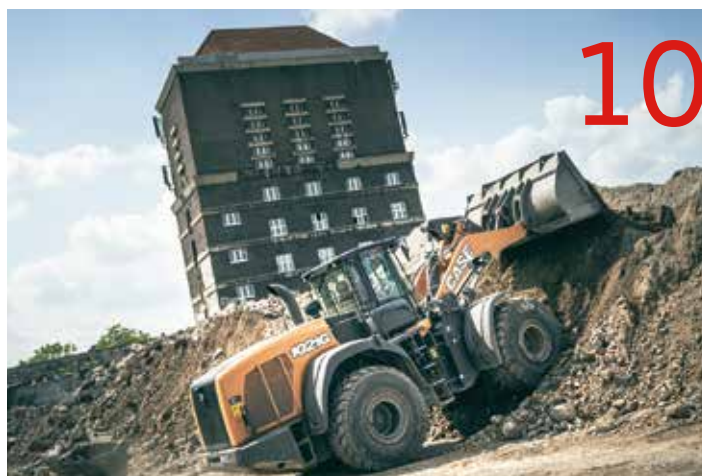
Die Bodensanierung im Kronprinzenviertel ist weitgehend abgeschlossen
