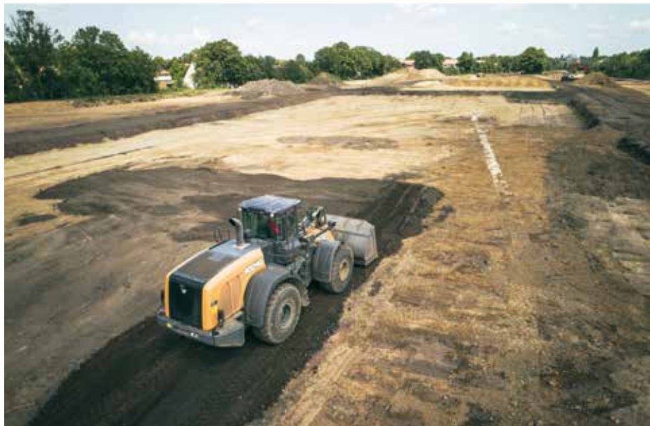
Impressionen von den laufenden Bauarbeiten im Rahmen der Bodensanierung im Sommer - Fotos (4): Philipp Berstermann.
