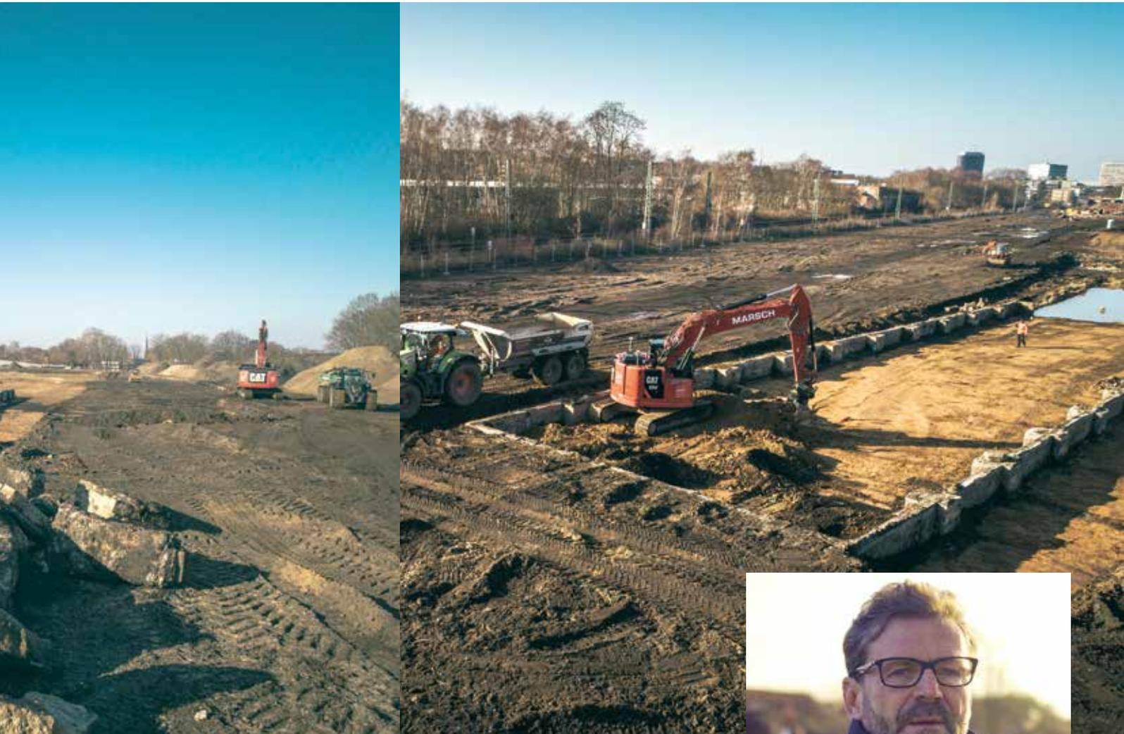
Anschluss werden wieder zwei Meter Boden aufgetragen. Die Bodensanierung und Erschließung - also der Bau von Wegen und die Verlegung der Ver- und Entsorgungsleitungen - werden voraussichtlich bis Mitte 2021 dauern. Rund 540 Tonnen Kalk wurden bereits auf dem Gelände eingebracht, um den nassen Baugrund zu stabilisieren. Insbesondere der Untergrund für die Ring-, Bau- und Zufahrtstraßen wird aktuell in einen bebaubaren Zustand versetzt.
