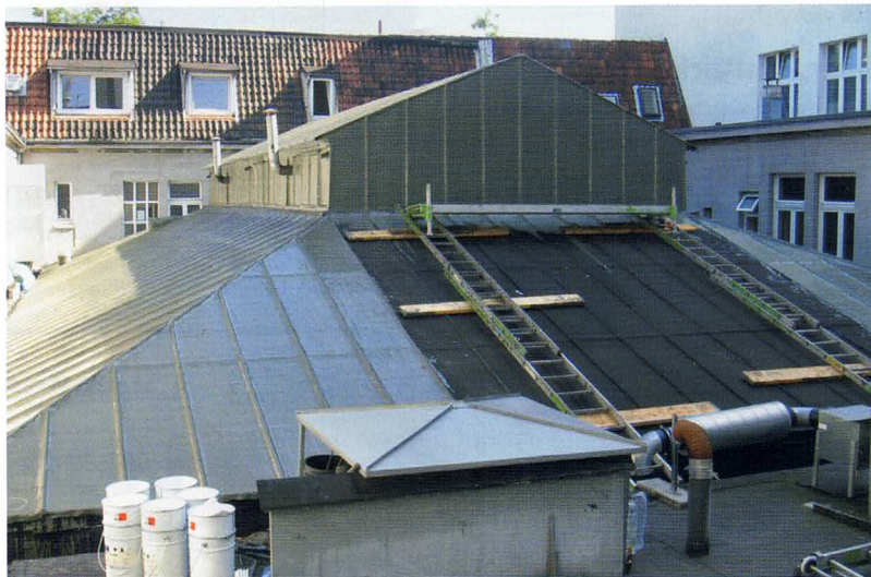
Das gestrichene Glasdach während der Abdichtungsarbeiten mit KEMPEROL®.
