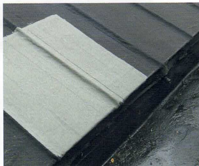
Die angelegte Musterfläche bewies die Haftung der Flüssigabdichtung auf dem Untergrund.
