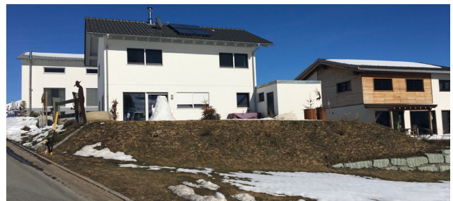
Abb. 26: Neue Einfamilienhäuser nördlich der Hauptstrasse
