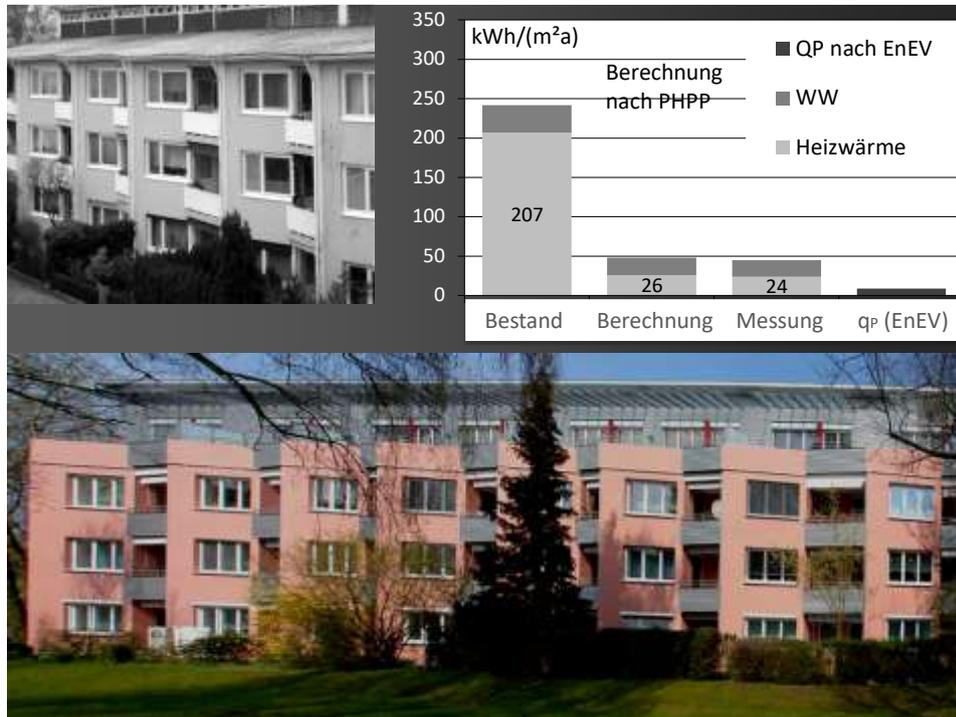
Abbildung 6 Energetische Gebäudesanierung Bernadottestraße 42 – 48 in Nürnberg unter Einsatz von Passivhaus-Komponenten. Der Heizwärmebedarf nach Sanierung lag bei 26 kWh/(m<sup>2</sup>a).
