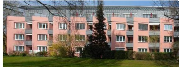
Abb. 12 Sanierung mit Passivhaus-Komponenten für den Bestand und Aufstockung mit sechs Passivhauswohnungen: Bernadottestraße in Nürnberg
