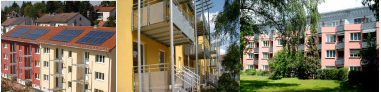
Abb. 1-3 MFH Passivhäuser / Sanierung mit Passivhauskomponenten: v. l. Dollmannstraße 47-55, Ansbach, Bauherr und Arch. St. Joseph Stiftung; Ingolstädter Straße 139-141, Nürnberg, Bauherr: wbg Nürnberg; Bernadottestraße 42 – 48, Nürnberg, Bauherr wbg Nürnberg, Arch. Schulze Darup & Partner
