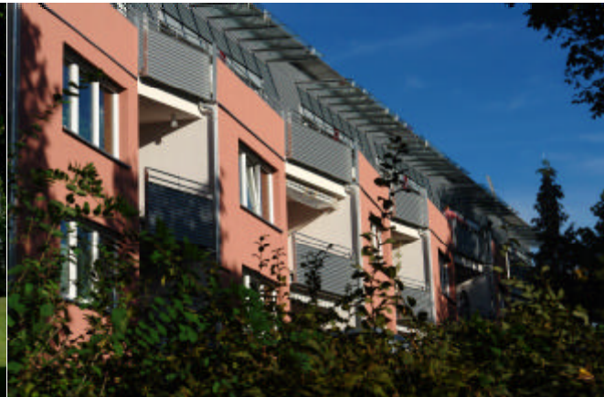
Abb. 2 Nach der Sanierung mit sechs zusätzlichen Passivhaus-Wohnungen im DG
