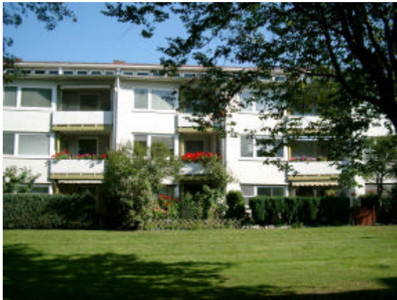
Abb. 1 Bernadottestraße 42 – 48 vor der Sanierung: 24 Wohnungen
