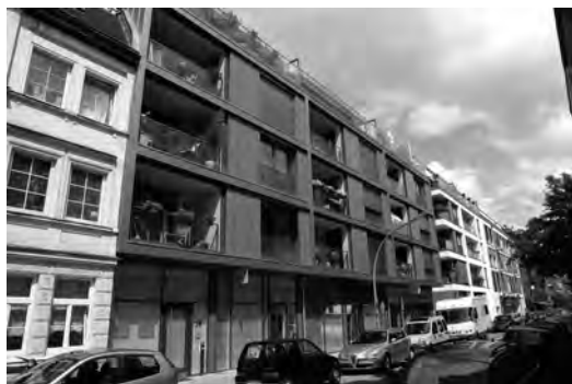
Bild 19. Ansicht von Südwest aus der Erdmannstraße
