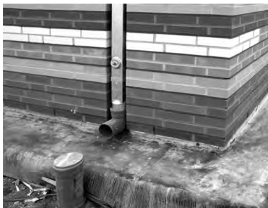
Bild 9. Sockelausführung bei zweischaligem Mauerwerk mit Verblender
