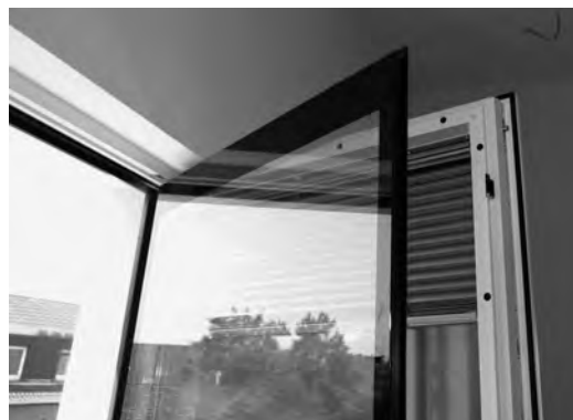
Bild 11. Holz-Alu-Fenster mit Dreischeibenverglasung und vorgesetzter Glasebene zur Abdeckung des Verschattungselements
