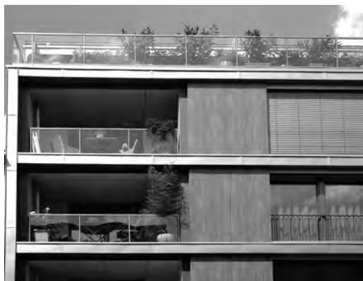
Bild 5. Vorhangfassade auf KS-Mauerwerk
