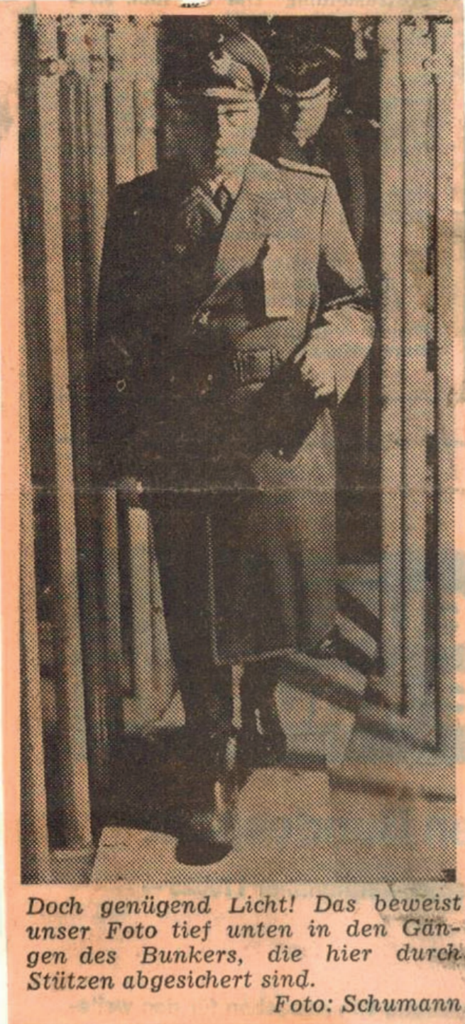
Doch genügend Licht! Das besichtigte unser Foto tief unten in den Gängen des Bunkers, die hier durch Stützen abgeleitet sind. Foto: Schumann
