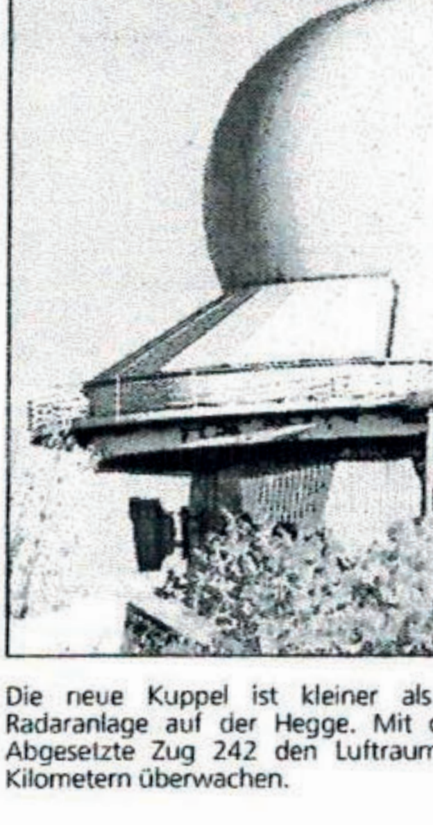
Die neue Kuppel ist kleiner als die bisherige Schutzhülle der Radaranlage auf der Hegge. Mit dem neuen Radargerät wird der Abgesetzte Zug 242 den Luftraum in einem Radius von gut 400 Kilometern überwachen. Fotos (2): Frank Queren
